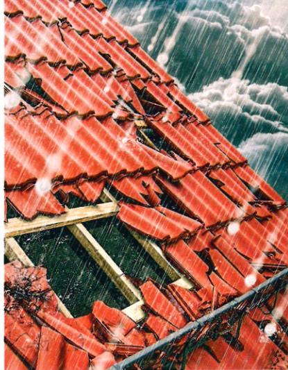
Ein zum Beispiel durch Sturmschäden undicht gewordenes Dach lässt Bausubstanz durchfeuchten und fördert Schimmelbildung. epr/Bauder
