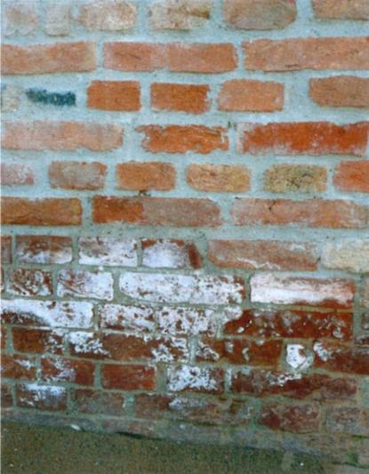
Im Bereich einer Kellerwand zeigen mineralische Ausblühungen, dass es ein Problem mit Feuchtigkeit im Mauerwerk gibt. epr/Aqualan
